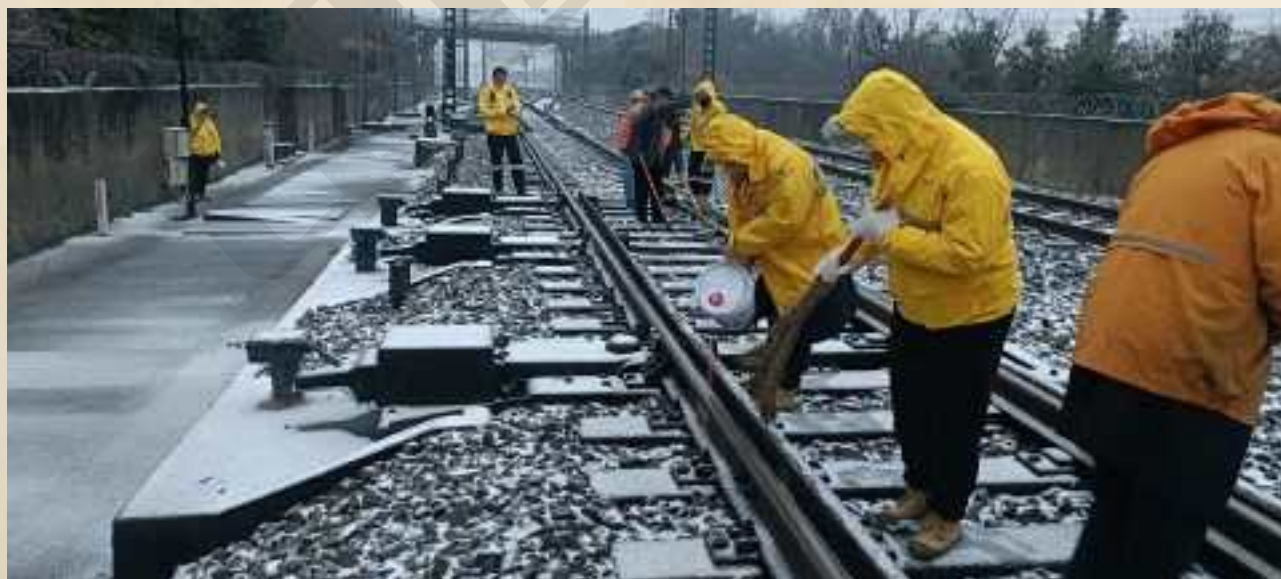
武汉桥工段，2200余名职工在隧道站区进行除冰作业
