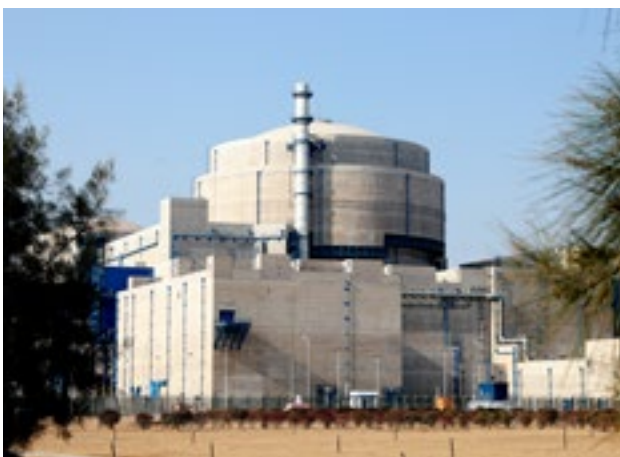
“华龙一号”示范工程福清核电6号机组
