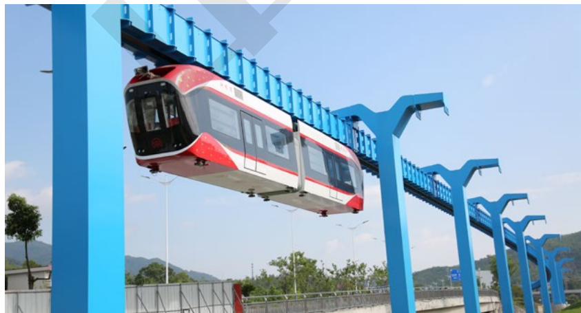
中铁工业参建的世界首条稀土永磁磁浮试验线“红轨”竣工
