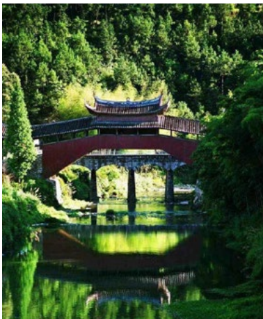
浙江泰顺县溪东桥
