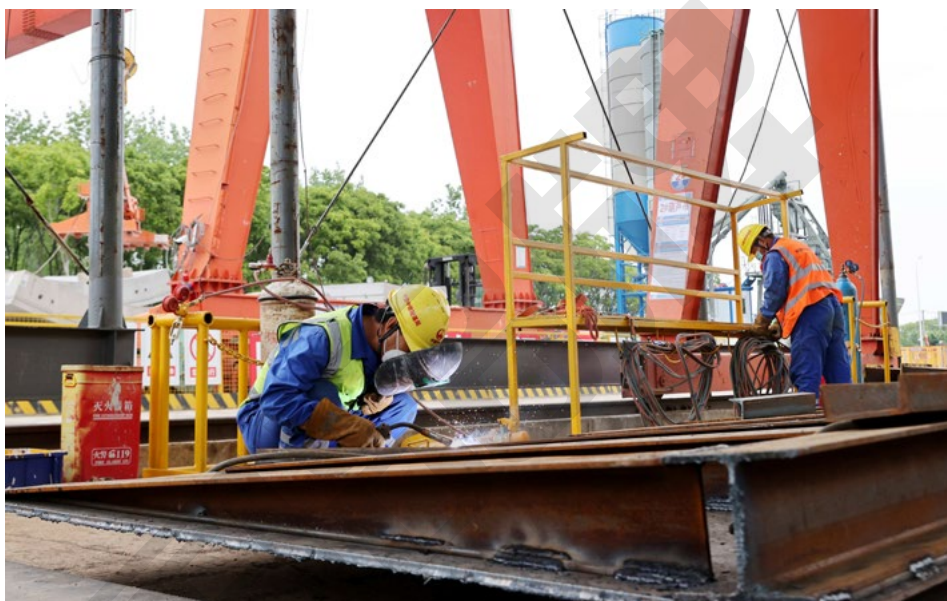
在上海轨道交通市域线机场联络线工程11标段，工人正在进行电焊作业
