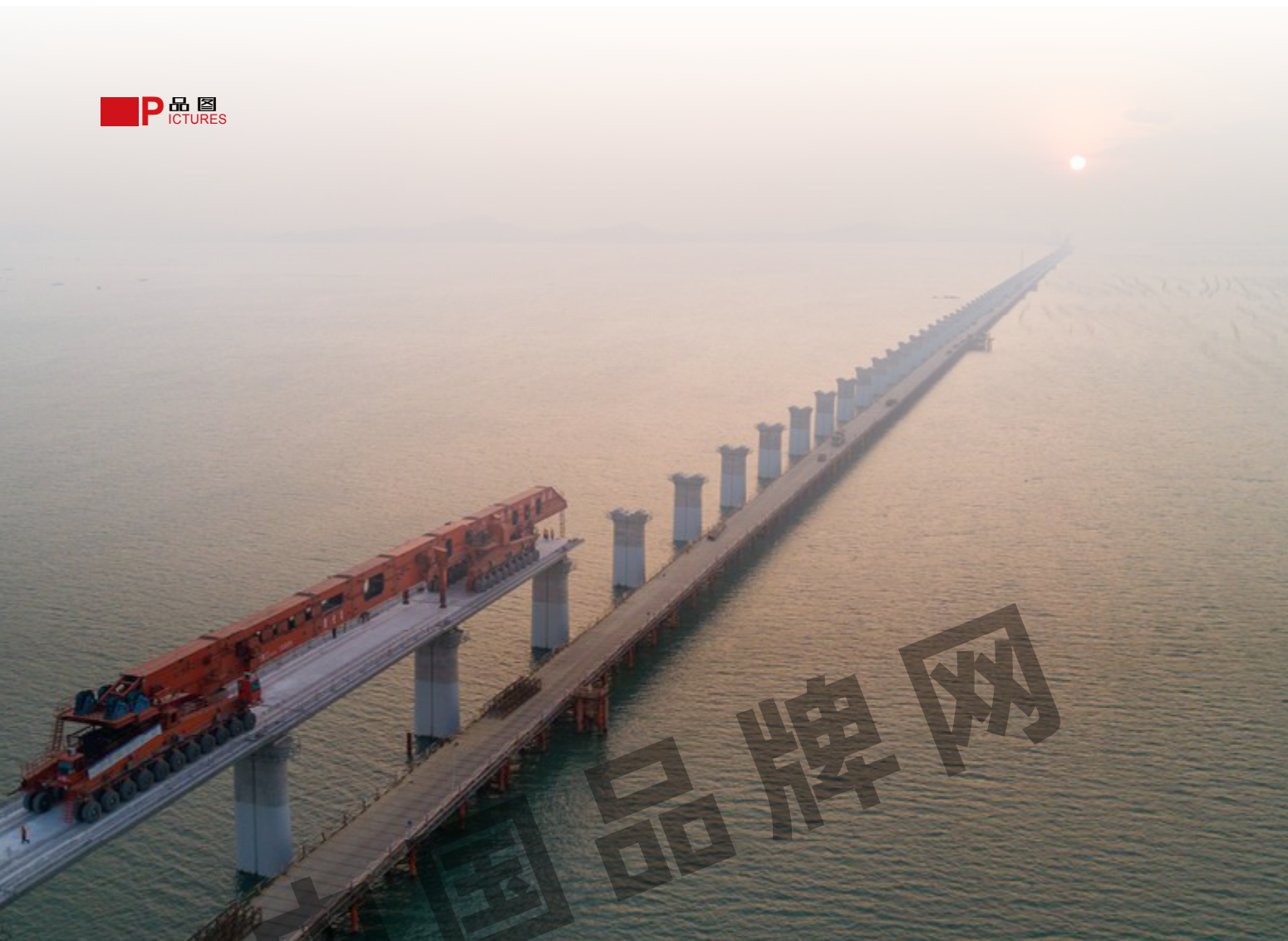
我国首条跨海高铁福厦铁路湄洲湾跨海大桥建设现场，中铁十一局的“昆仑号”千吨级运架一体机在夕阳中作业
