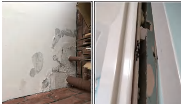
装修后房屋出现漏水、门框脱落等问题
