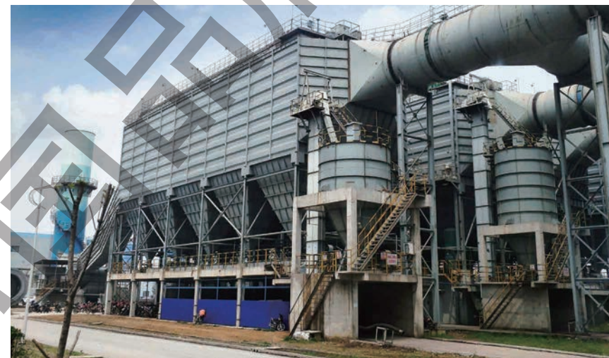
袋式除尘器安装现场
