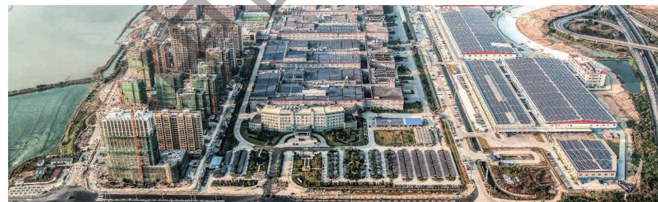
由隆基新能源建设的宁德新能源分布式光伏项目
